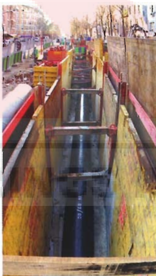
Des blindages jointifs coulissants simple glissière sont également présents sur le chantier.
