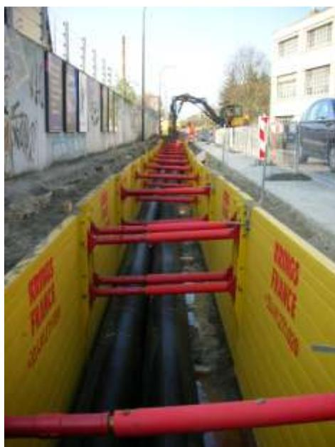
D'après la profondeur à atteindre, les caractéristiques de travaux à réaliser, la nature du terrain rencontrée ainsi que les capacités de levage de l'engin de manutention, le caisson KS répond parfaitement aux besoins du chantier.
