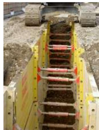
Le blindage ayant atteint la cote définitive, le réglage du fond de forme peut commencer. Dans certains cas, un béton de propreté est coulé, les panneaux servent alors de coffrage extérieur. Selon l'épaisseur du béton prévoir des feuilles de polystyrène à appliquer entre les panneaux et le béton.
